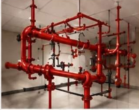
نظام الرش مسبق التشغيل Pre-Action System
